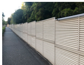
▲ 塀・柵等による分断②
