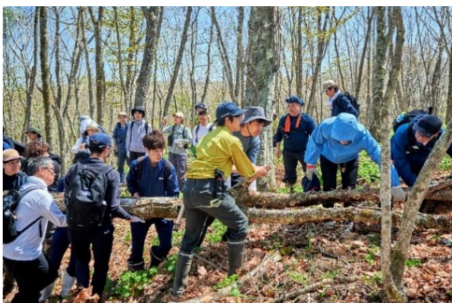
2026 年 5 月に環境省、鶴居村の関係者で行った 林道整備の様子
