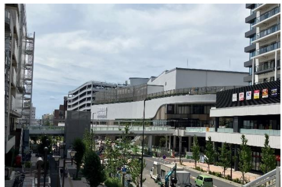
エミテラス所沢外観（2024 年 7 月 31 日撮影）
