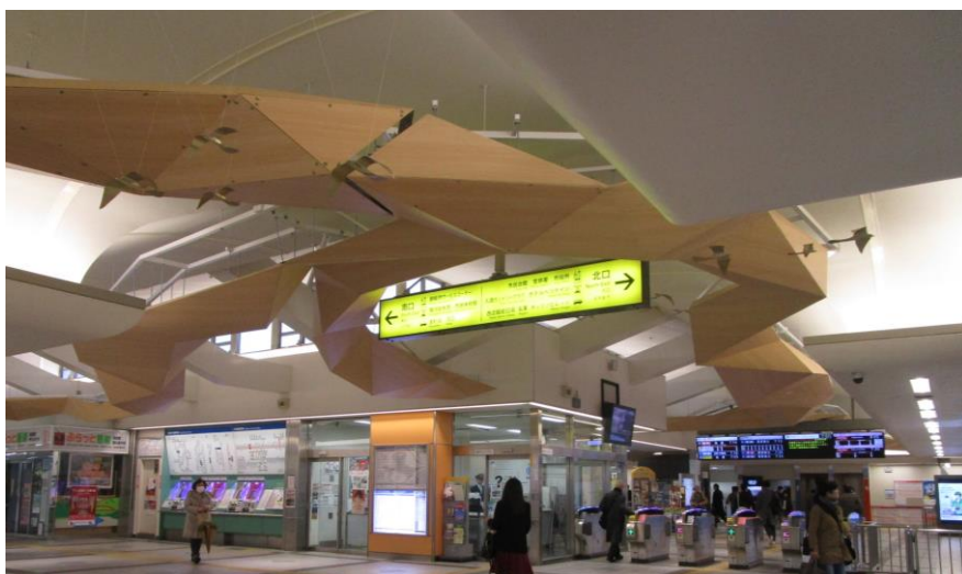
飯能駅改札外コンコース 工事進捗状況(2019年3月1日時点)
